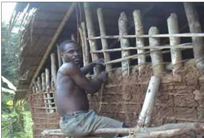
Construction de maison © CED
